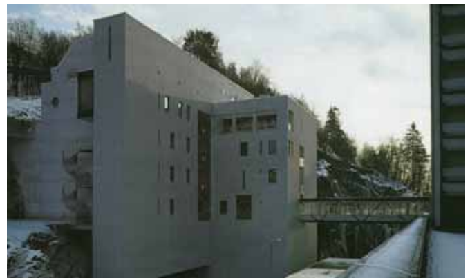
Fig 12-6. Vivarium 1993. Photo: Statsbygg
